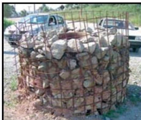
Figura 14 - Exemplo de dreno típico de aterro, que pode ser adaptado e inserido no sistema de captação de biogás (Fonte: ICLEI, 2009, adaptado do acervo CENBIO).
