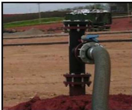
Figura 13 - Captação de Biogás em aterro Sanitário - Aterro da Essencis CAIERAS (Fonte: Assis, 2009, adaptado de CENBIO, 2006).
