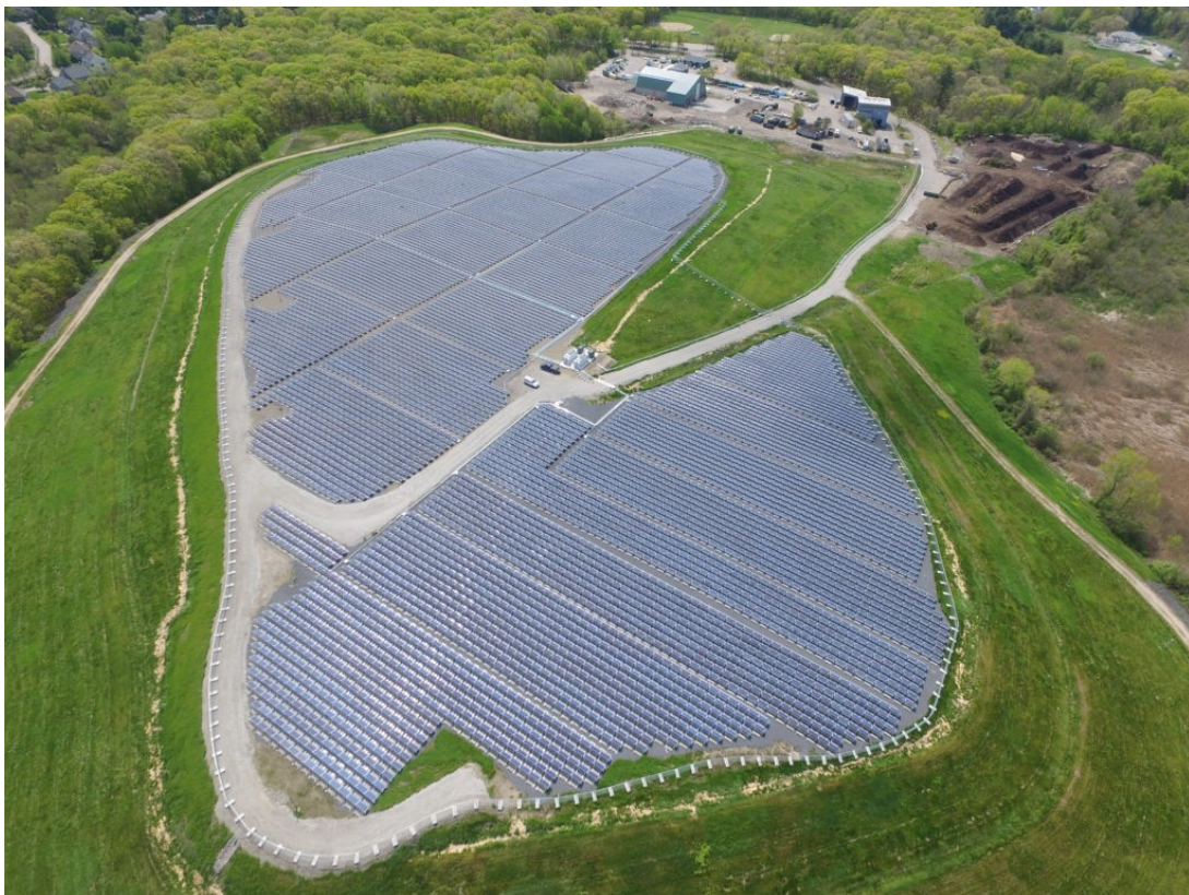
Figura 3.8: Sistema Fotovoltaico no aterro de Needham – MA/EUA (Fonte: [18]).
