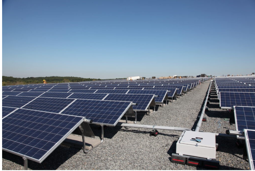
Figura 4.3: Módulo Cristalino implementado em Aterro (Fonte: [18]).
