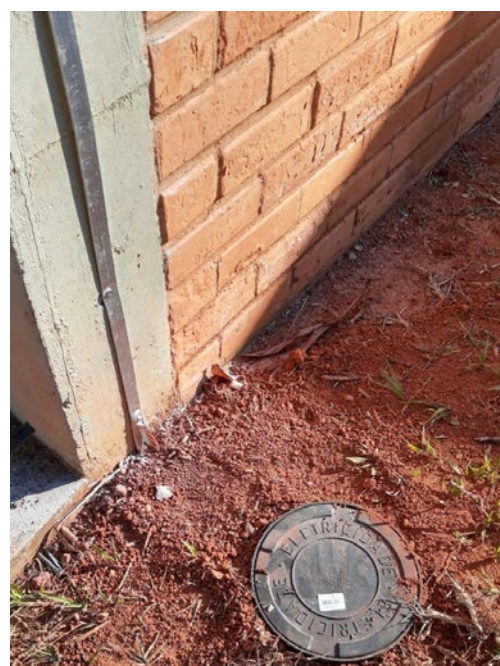
DETALHE 3 - DETALHE DE DESCIDA EM BARRA CHATA DE ALUMÍNIO COM O ATERRAMENTO
